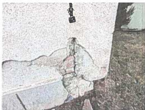
Poza 10. Degradări la nivelul tencuielii exterioare și a soclului
